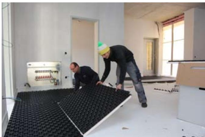
In den letzten Monaten wurde der Innenputz angebracht sowie der Trockenbau und alle Rohinstallationen für Strom, Wasser, Abwasser und das Heizungssystem hergestellt. Ebenfalls konnten die Ausgleichsschüttung samt Dampfsperre und Dämmung fertiggestellt werden. In
